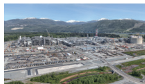
LNGカナダプロジェクト（建設中）
